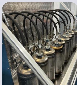
УЧАСТОК ГИДРОСТАТИЧЕСКИХ ИСПЫТАНИЙ
